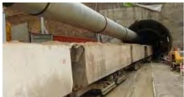
شکل (۱): سیستم ترابری ریلی استفاده شده در پروژه تونل بلند زاگرس
