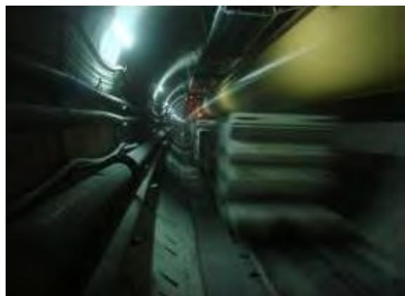
شکل (۳): استفاده از روش تخلیه پیوسته مصالح حفاری شده (نوار نقاله) در پروژه توول زاگرس
