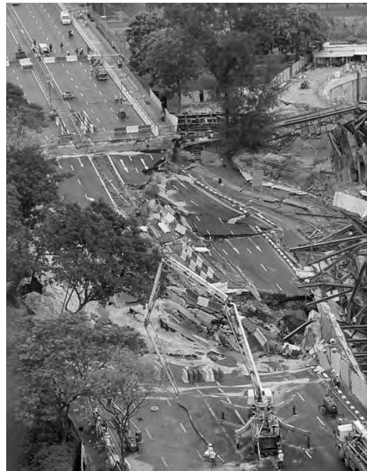
شکل ۸. خسارات ایجاد شده دراثر ریزش تونل MRT در سنگاپور [۷]
