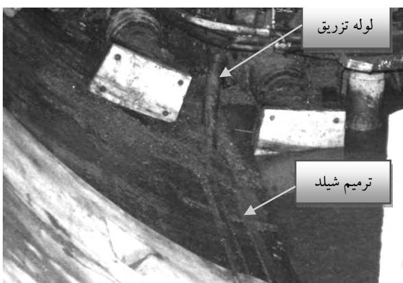
شکل ۱۱. نمایی از لوله‌های نصب شده جهت تزریق در کف شیلد انتهایی به همراه حفاظ روی آن جهت ترمیم شیلد
