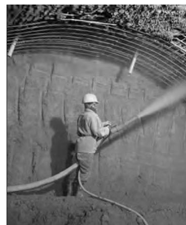
شکل ۱۰- نمونه‌ای از اختلاط فیبرهای فولادی را با مصالح بتون پاشیده قبل از پاشیدن [۶].
