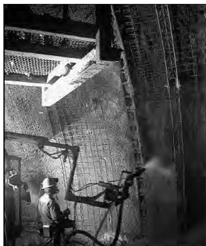
شکل ۱۱- اجرای بتون پاشیده توسط تجهیزات روباتیک [۱۱].
