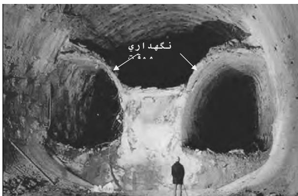
شکل ۶- استفاده از پوشش موقعی در حفاری تونل با مقطع بزرگ [۷].
