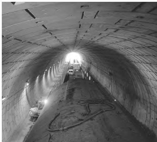
شکل ۲- به کار گیری قطعات پیش ساخته بتنی جهت نگهداری نهایی تونل میلان-رم [۷].
