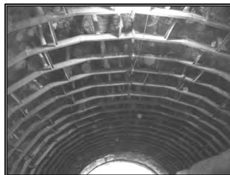
شکل ۵- به کار گیری قاب‌های فولادی و معضل اضافه حفاری در تونل راه
