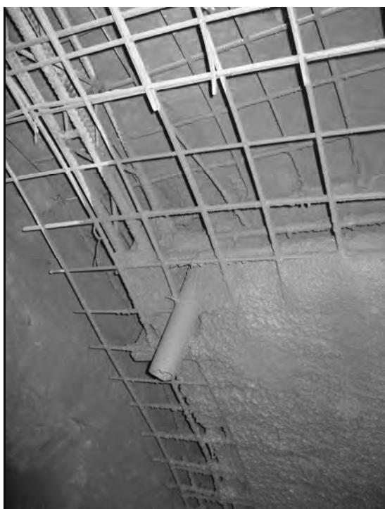
شکل ۹- نصب دو لایه شبکه فولادی جوشی به صورت همزمان و سپس به کارگیری بتن پاشیده
