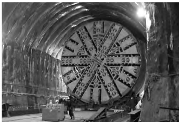
شکل ۱۱- تغییر جهت ماشین سپری: (الف) توب‌های لغزان، ب) نحوه کشیدن ماشین
