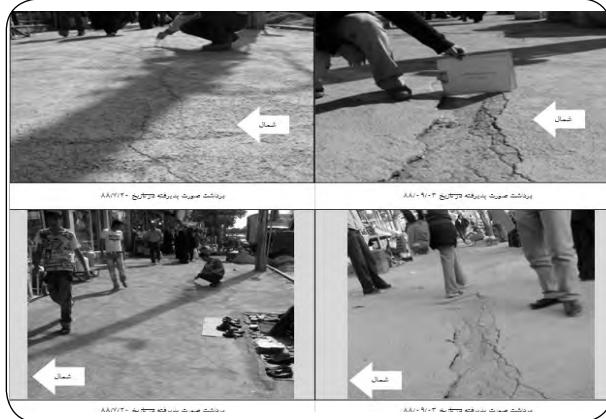
شکل ۷. نمایی از برداشت درزهای سطحی قبل و بعد از عملیات حفاری تونل
