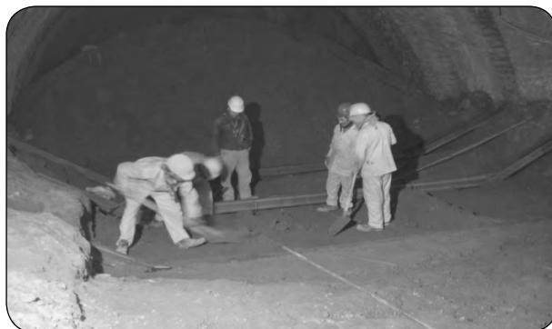
شکل ۱۹. نمایی از عملیات تقویت سازه نگهداری و تکمیل رینگ نگهداری پس از ثبت نشست و همگرایی با آهنگ زیاد
