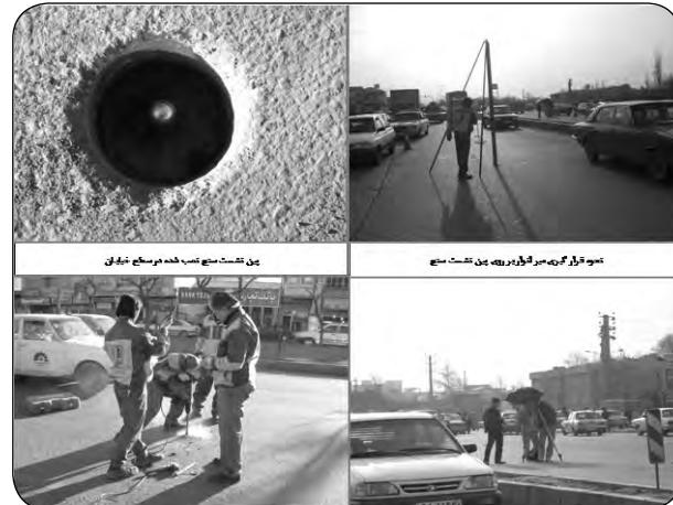
شکل ۶. نمایی از پین نشست سنجی نصب شده در آسفالت و طریقه قرائت ایستگاه‌های نشست سنجی
