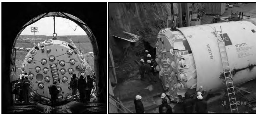
شکل ۱. نمایی از ماشین و کله حفاری آن در پروژه قمرود
