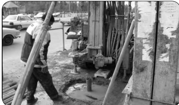
شکل ۱۸. نمایی از عملیات Soil Nailing در مقطع کیلومتراز ۱+۶۲۵ جهت بهسازی زمین پس از ثبت نشست بانو خ بالا
