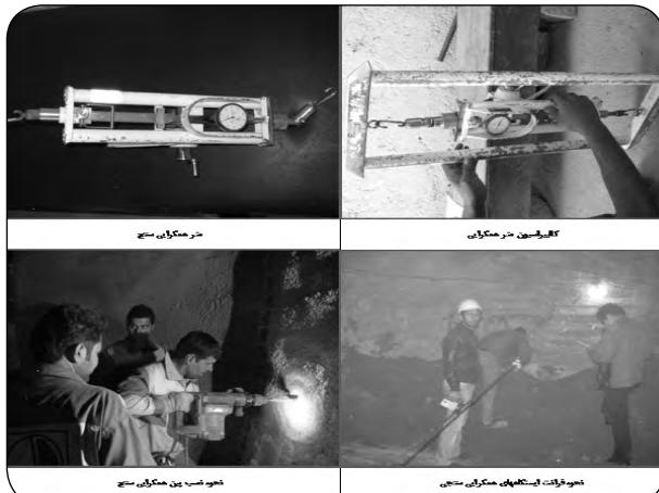
شکل ۴. نمایی از طریقه نصب و قرائت ایستگاه همگرایی سنجی در تونل
