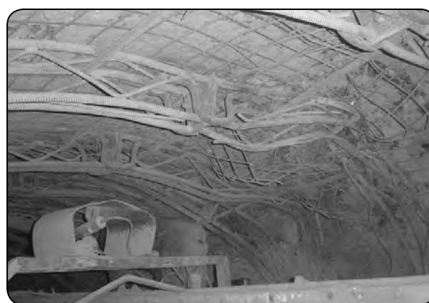
تصویر ۳: نحوه تغییر شکل سیستم نگهداری اولیه تونل [۳].
