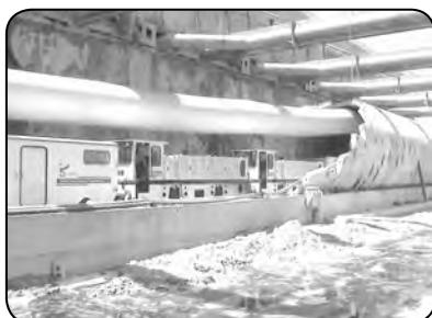
تصویر ۲: شفت دو قطار شهری شيراز، تغذیه T.B.M و تخلیه مصالح به کمک دو سری لوکوموتیو Schoma-Cfl-180.Dcl انجام می شود، حمل و نقل نفرات به کمک واگن نفر بر صورت می گیرد، داکت تهويه تونل به قطر ۱.۶ متر در بالای ترن دیده می شود، (شروع حفاری در این ایستگاه بدون استفاده از سازه Push Frame و با یک روش ابتکاری شامل چیدمان سگمنت ها به ترتیب از یک عدد در کف و افزایش تا شش عدد، رینگ کامل انجام شده است).
