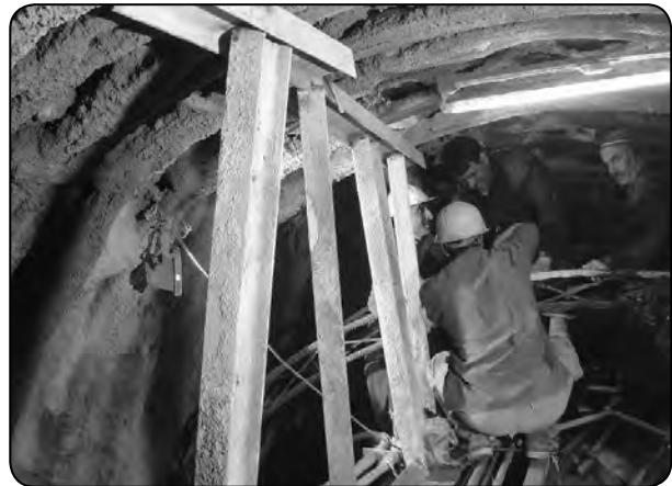
تصویر ۵: عملیات نصب قابهای مقطع اصلی به صورت رینگ کامل [۳].
