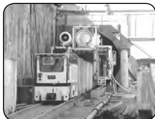
تصویر ۵: سیستم تهویه ماشین حفار شامل کست داکت قطر ۱,۶ متر و مکنده ۳ کیلووات Back up ماشین حفار قابل تشخیص است. لوکوموتیو در حال بارگیری می‌باشد. شروع حفاری تونل به کمک E.P.B.M در ایستگاه مبدأ حفاری، میدان الله
