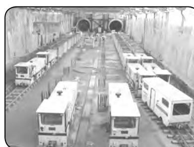
تصویر شماره ۱: تونل های قطار شهری شيراز که توسط دو عدد E.P.B.M در حال حفاری می باشند (شروع حفاری مهر ۱۳۸۲، قطر داخلی تونل ۶ متر، قطر خارجی سگمنت ۶.۶ متر، قطر حفاری ۶.۶ متر و محل تصویر شفت میدان الله
