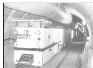
شکل ۲- عکسی از مقطع توول، داکت تهویه و سیستم حمل و نقل
