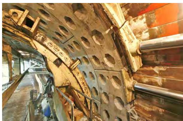
شکل ۱۱- حرکت شیلد به سمت جلو با استفاده از فشار جکها به آخرین رینگ سگمنت نصب شده
