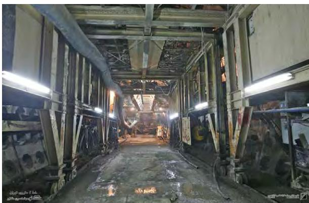
شکل ۱۰- محل قرارگیری پاور پک دستگاه حفار زوکور بر روی گنتری‌ها (کارگاه حفاری قطعه Q4-R4 خط ۴ متروی تهران)
