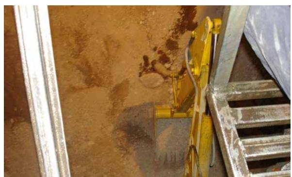
شکل ۴- بیل مکانیکی جهت انتقال خاک حفاری شده توسط رودهدر مخروطی بر روی نوار نقاله؛ بکار رفته در عملیات حفاری خط ۴ متروی تهران
